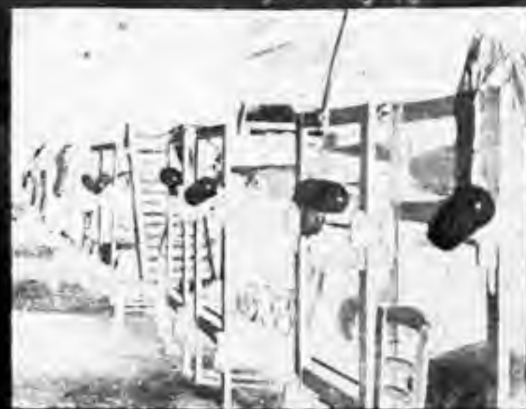
Abb. 8. Baracken-Entlausung mit VENTOX, VENTOX-Verdunster an den Bollgestellen.
